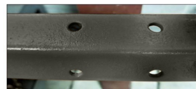
Dura-Coat OX aplicado sobre a corrosão
